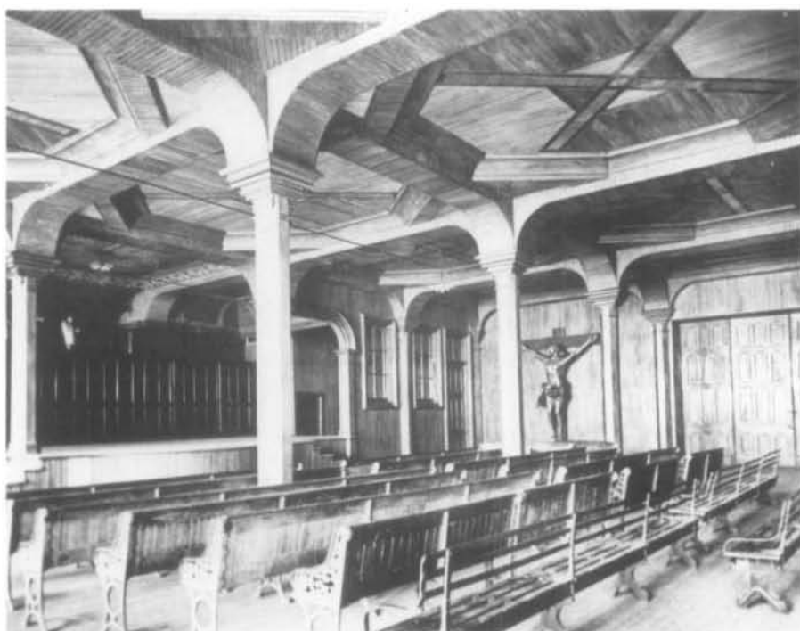
fig.9 La salle de réunion sous la chapelle dans son état d'origine. (Photo: Archives de la paroisse de Notre-Dame.)
