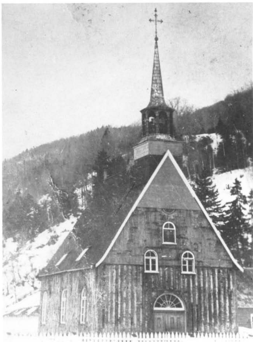
(1) Ancienne église de la paroisse Saint-François-Xavier-de-la-Petite-Rivière, construite en 1777-78 et démolie en 1903. (Photo Inventaire des biens culturels du Québec — dorénavant Photo IBC).
