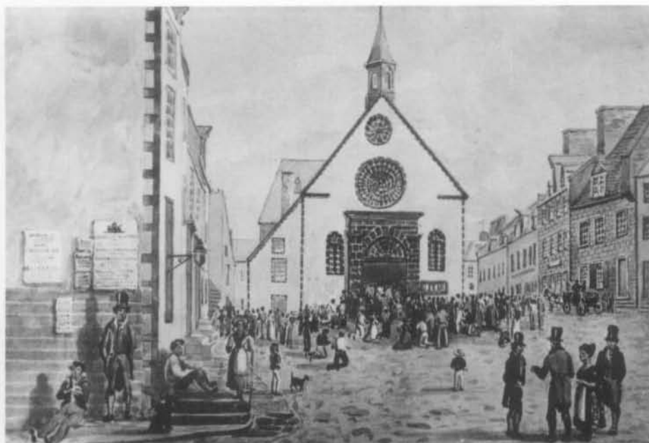
Fig. 7 Eglise Notre-Dame-des-Victoires, Vue de l'édifice en 1830; aquarelle de J. P. Cockburn. Façade réalisée en 1816 d'après les plans de François Baillairgé. (Photo: Inventaire des Biens Culturels, Québec).
