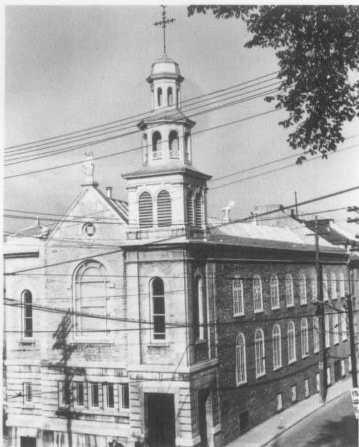
Fig. 12. Chapelle de la Congrégation Notre-Dame, Québec. Vue de l'édifice après la restauration de 1930; Robitaille et Desmeules, architectes. (Photo: Inventaire des Biens Culturels, Québec).
