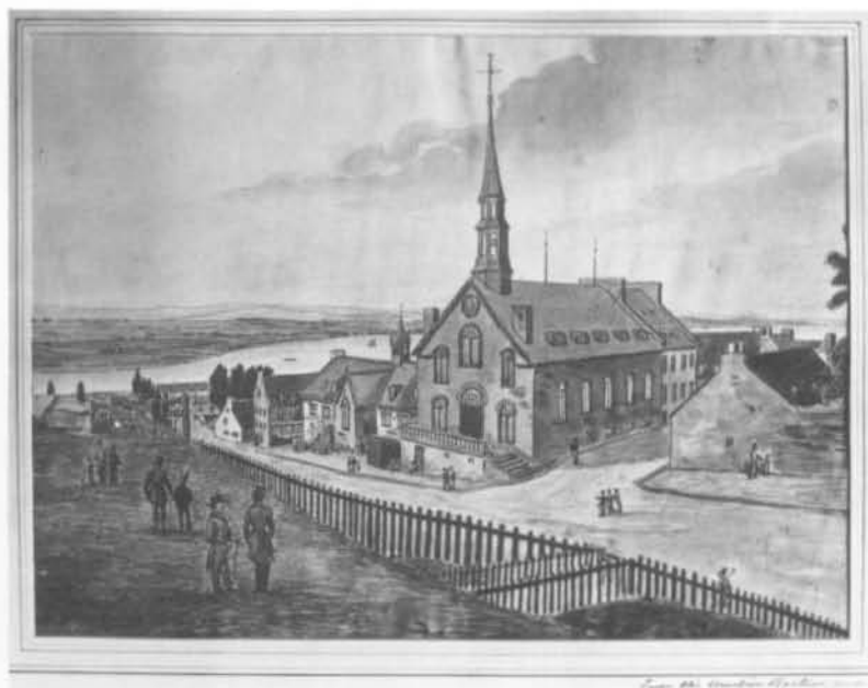
Fig. 6. Chapelle de la Congrégation Notre-Dame, Québec. Vue de l'édifice en 1829; aquarelle par J. P. Cockburn. (Photo: Archives publiques du Canada).
