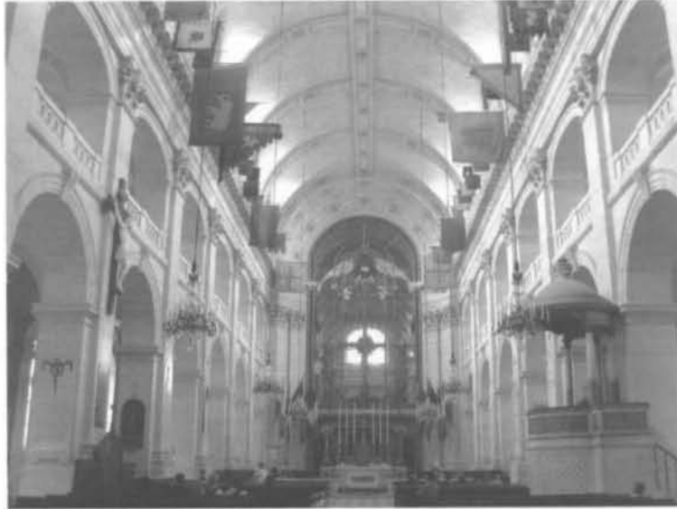
fig.14 Jules Hardouin-Mansart, Église Saint-Louis des Invalides (Église des soldats), commencée en 1676, Hôtel des Invalides, Paris. (Photo: Marc Grignon, 2005)
