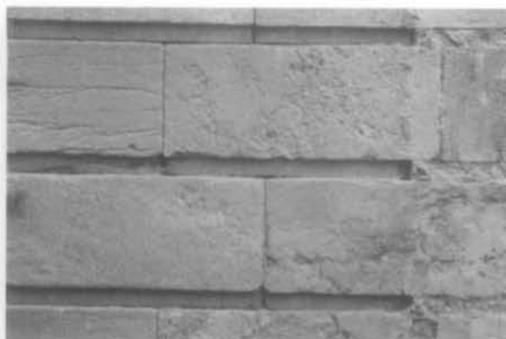
fig.4 Maçonnerie à bossage continu en table à anglet, juin 1999. (Photo: Jean Bélisle)
