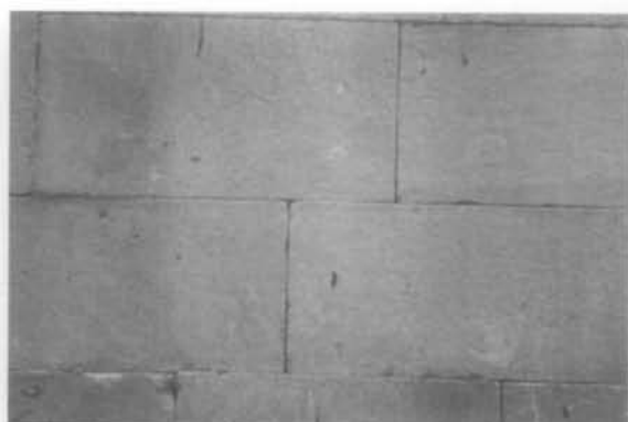
fig.5 Maçonnerie à appareil régulier allongé, juin 1999. (Photo: Jean Bélisle)
