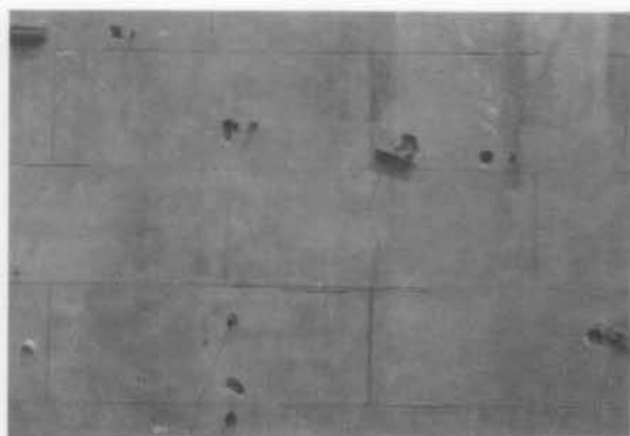
fig.10 Fausse pierre de taille avec faux joints tirés à la pointe, juin 1999. (Photo: Jean Bélisle)
