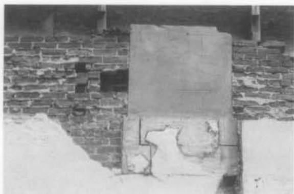
fig.12 Souche de cheminée du mur ouest, juin 1999. (Photo: Jean Bélisle)
