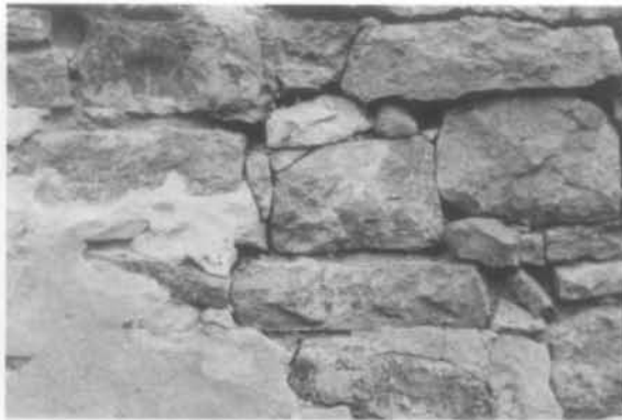
fig.8 Maçonnerie de moellons, juin 1999. (Photo: Jean Bélisle)
