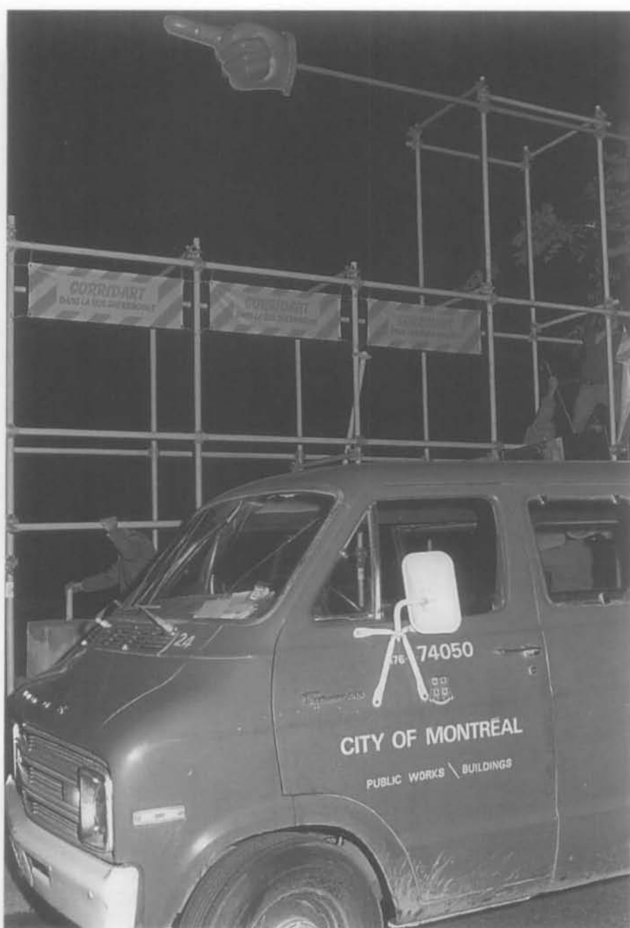
fig. 30 Démolition of/Démolition de Corridart . (Photo: Yvan Boulerice)
