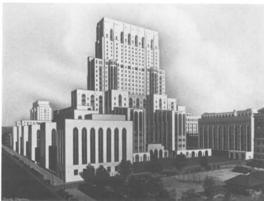
fig. 12 Cornell Medical Center, vue d'ensemble, photographie retouchée tirée de Bryant Hospital Devices, Montréal, Collection Centre Canadien d'Architecture / Canadian Centre for Architecture, ARO1:408/A-14. (Photo : reproduite dans Ernest Cormier et l'Université de Montréal , Isabelle Gournay, éd., Montréal, Centre Canadien d'Architecture, 1990, p. 77)
