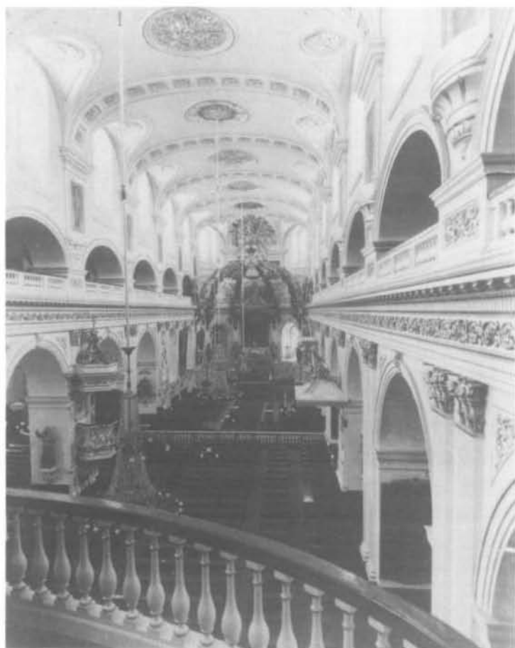
fig.6 François Baillairgé, Fausse-voûte de l'église Notre-Dame de Québec, 1818 (restaurée en 1920-21). Premier exemple au Canada d'une fausse-voûte de bois recouverte en plâtre pour imiter une voûte de pierre. (Photo: Archives nationales du Québec.)
