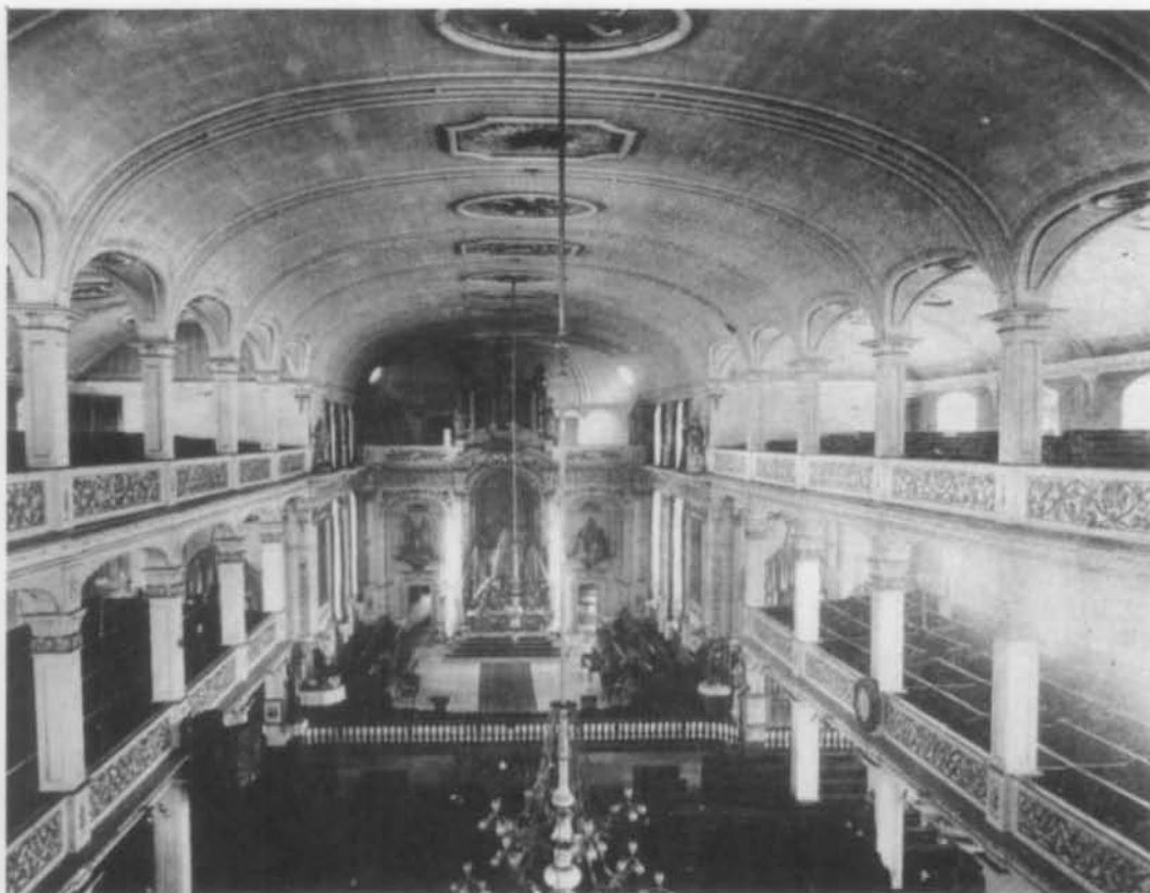
Fig. 2. Louis Thomas Berlinguet (1848) d'après le modèle en bois de Raphaël Giroux, Saint-Roch, Québec, 1848. Intérieur de l'église démolie en 1914 (Photo: I.O.A.).
