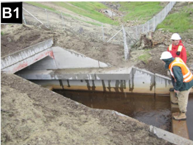
Ponceau avec pied-sec de type tablette en porte-à-faux préfabriqué en béton.
