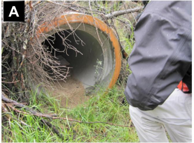
Pied-sec de type tuyaux de béton armé d'un diamètre de 60 cm ou de 90 cm.
