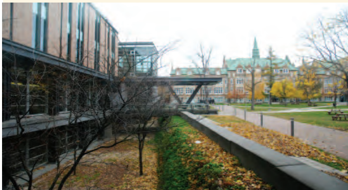
Le Complexe des Sciences Richard-J.-Renaud (SP) sur la gauche et le Pavillon Central (CC) au loin sur la droite (Source : JP photographe)
