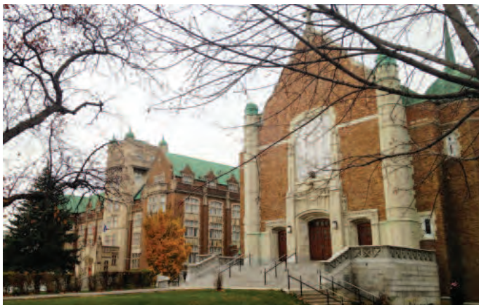
Faisant face à la rue Sherbrooke Ouest, la Chapelle (FC) à droite, et plus en recul et à gauche, le Pavillon administratif (AD) (Source : JP photographe)
