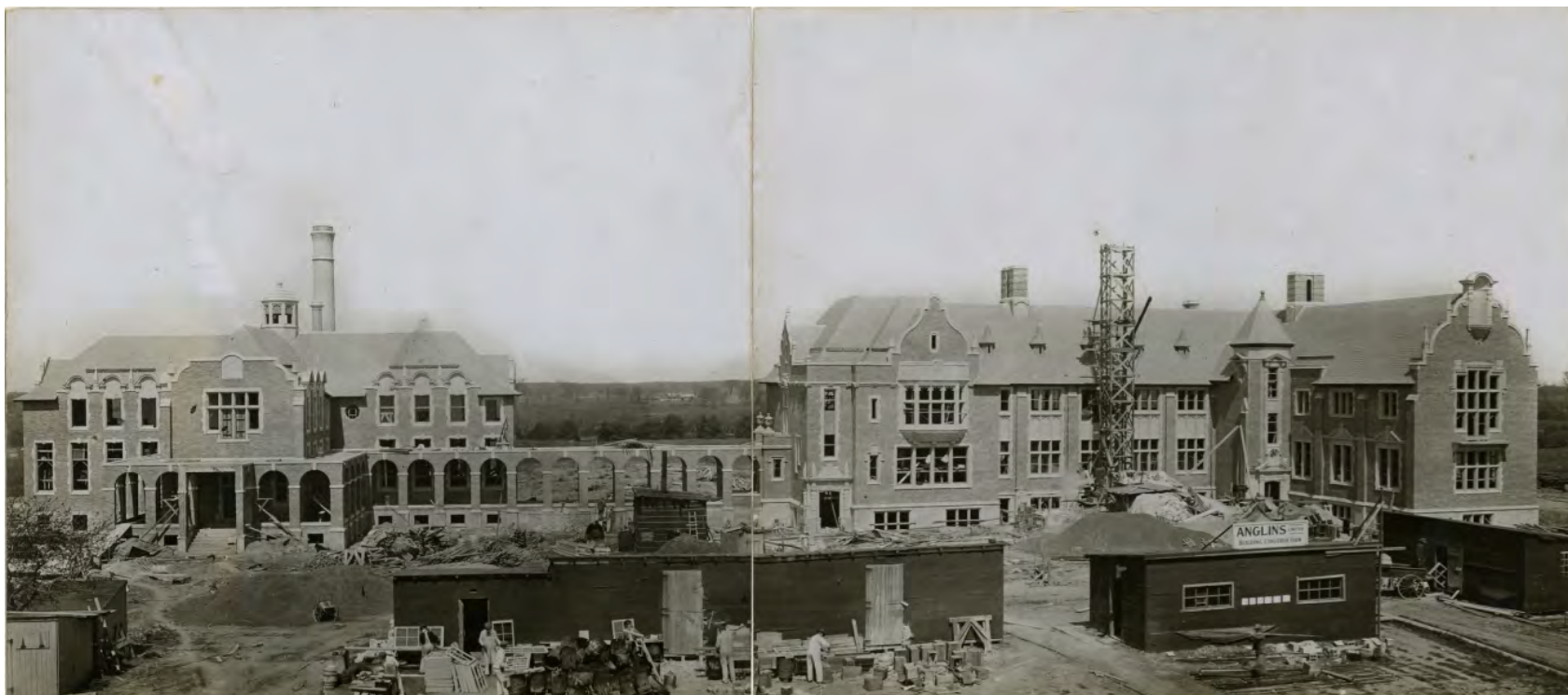
4.17 Le Réfectoire (RF), à gauche, et le Pavillon Junior (PY), à droite, sous construction, vus du sud (I147-02-087, UC-GDA)
