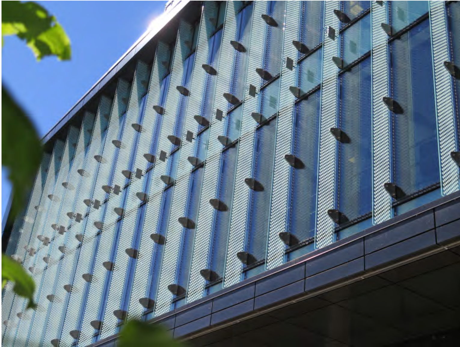
4.193 Détail du mur extérieur avec des brise-soleil verticaux de verre (Susan D. Bronson, 2016)
