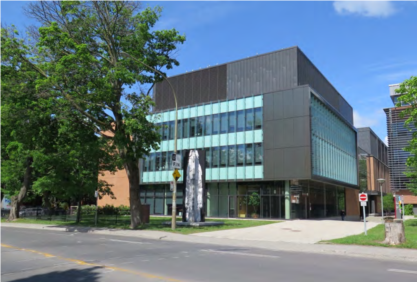
4.192 Le Centre de génomique structurale et fonctionnelle (GE), vu depuis la rue Sherbrooke Ouest (Susan D. Bronson, 2016)
