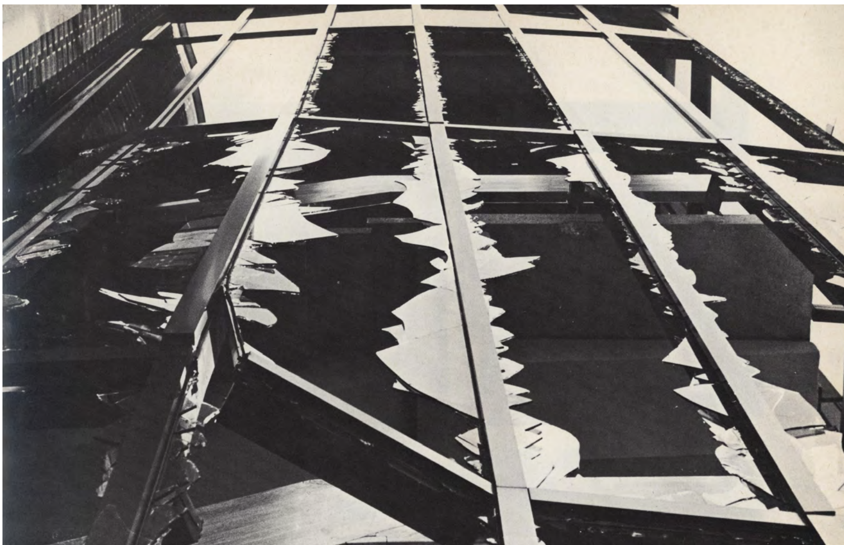
4.91 Le mur rideau de l'escalier sud du Pavillon Bryan (SP) après l'explosion d'une bombe le 20 novembre 1969 ( Loyola College Review , 1970 (n° 56), UC-GDA)
