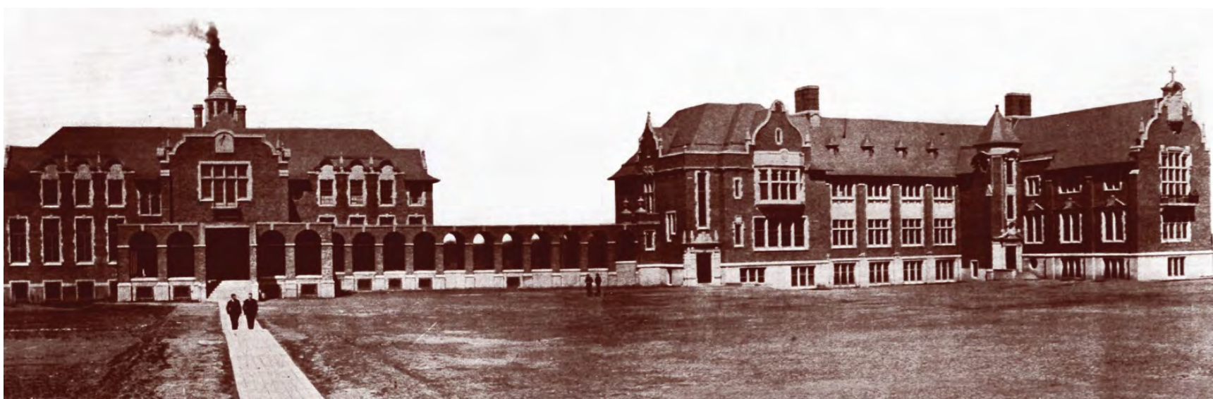
4.19 Le Réfectoire (RF) (à gauche) et le Pavillon des Juniors (PY) (à droite), vus du sud vers 1916, suite à l'achèvement de leur construction, et le sentier de bois qui les lie au Pavillon administratif (AD) ( Loyola College Review , 1916 (n°2), UC-GDA)
