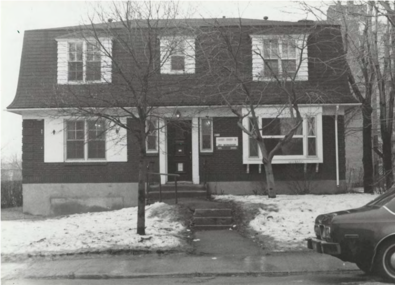
4.108 Siège du Loyola Peace Institute, créé par des membres de la Communauté Jésuite de Loyola et d'autres personnes et financé par cette communauté, dans une maison louée au 2480, rue West Broadway; l'institut fermera ses portes en 2004 et le bâtiment sera démoli en 2010 (I049-02-240, UC-GDA)
