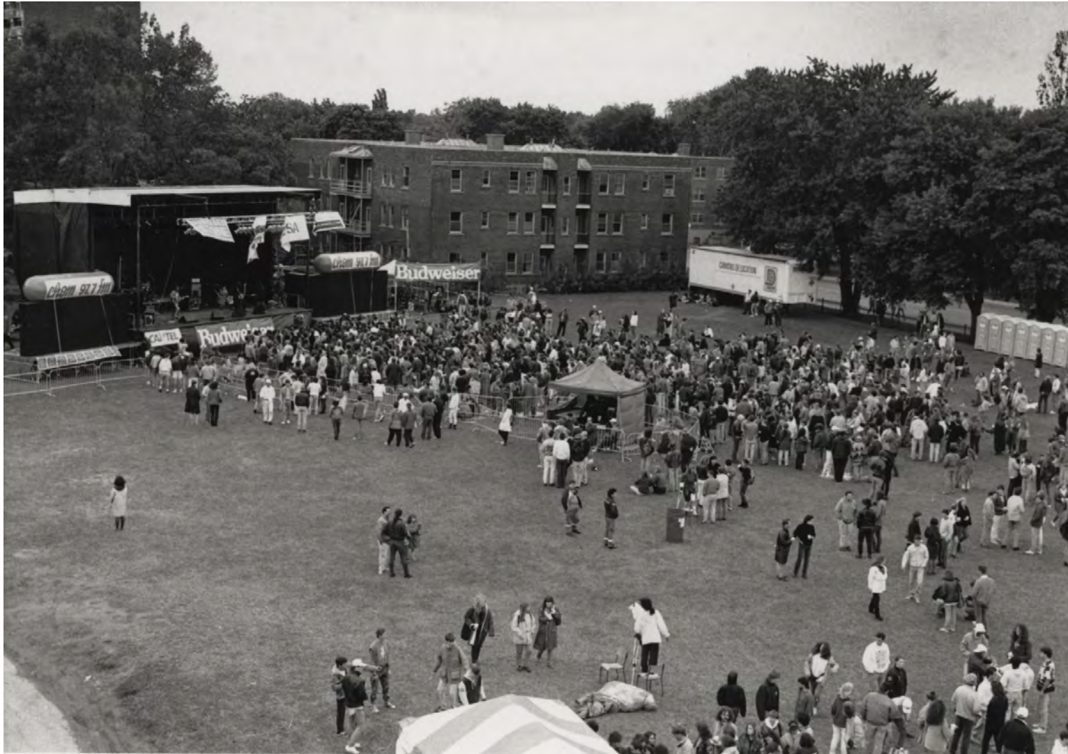
4.144 Vue vers l'ouest du nouveau stade lors d'un concert en plein air sur la pelouse entre le gymnase de l'École secondaire et la rue Sherbrooke Ouest, vers 1990; au fond, les Pavillons Hackett et Cloran seront bientôt démolis pour construire la nouvelle École secondaire Loyola (boîte HA 4881, UC-GDA)
