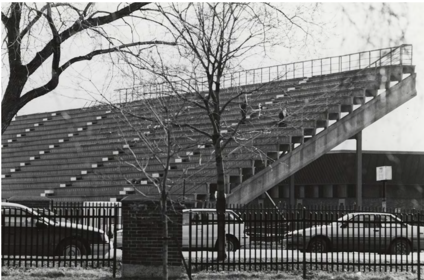
4.142 Nouvelle estrade de béton, suite à son réassemblage en 1989 (HA4881, UC-GDA)
