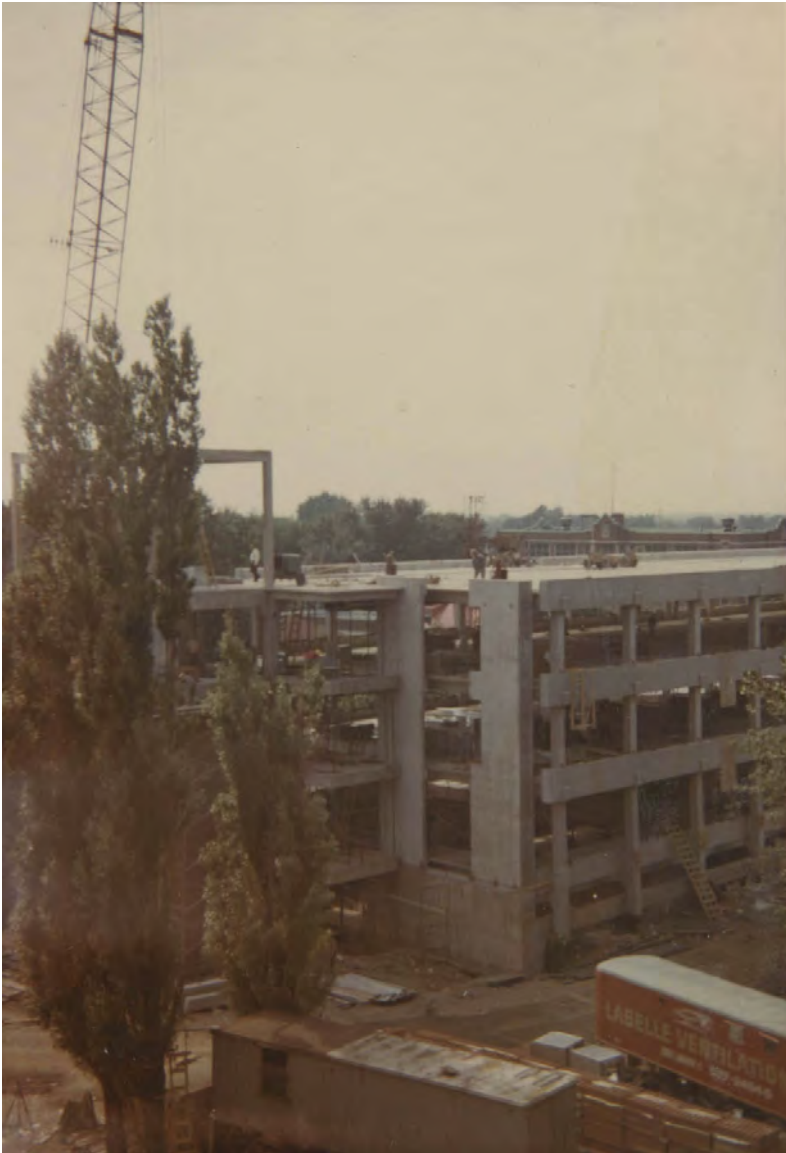
4.87 Les murs et dalles de béton pré-coulé du Pavillon Bryan (SP) en 1967 (I002-02-080, UC-GDA)
