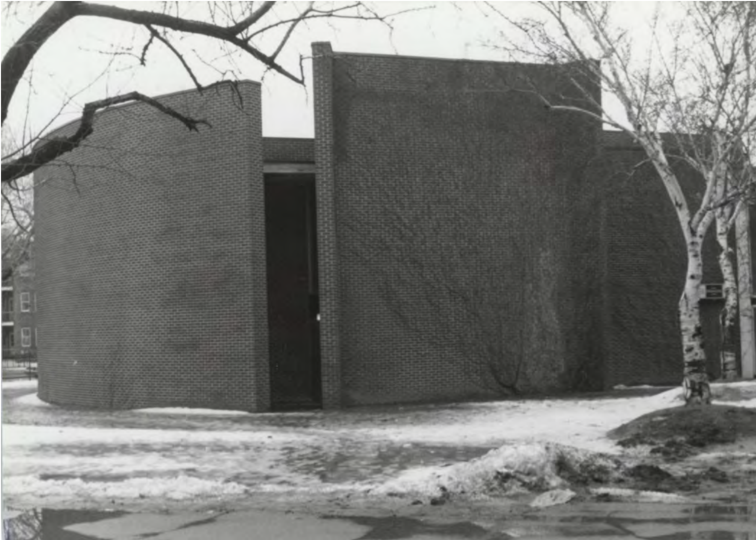
4.63 Vue à partir du sud-est de l'Auditorium Drummond, un volume en forme d'éventail dont les murs de brique rouge en courbe sont aveugles, situé au sud du bloc principal (1049-02-265, UC-GDA)
