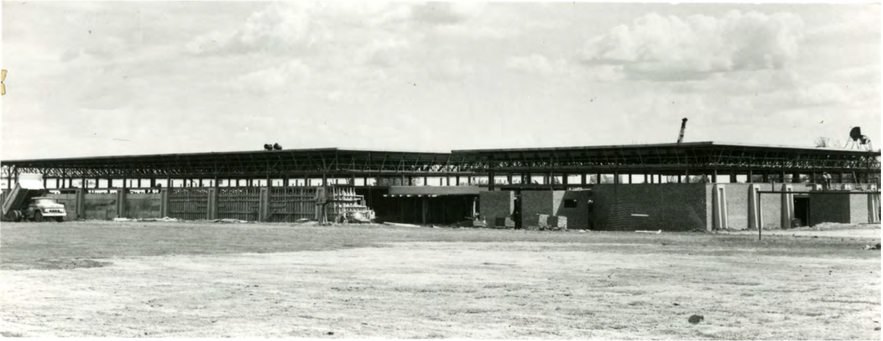
4.78 Photo du Complexe sportif (RA) en construction, 1966 (I002-02-3741, UC-GDA)
