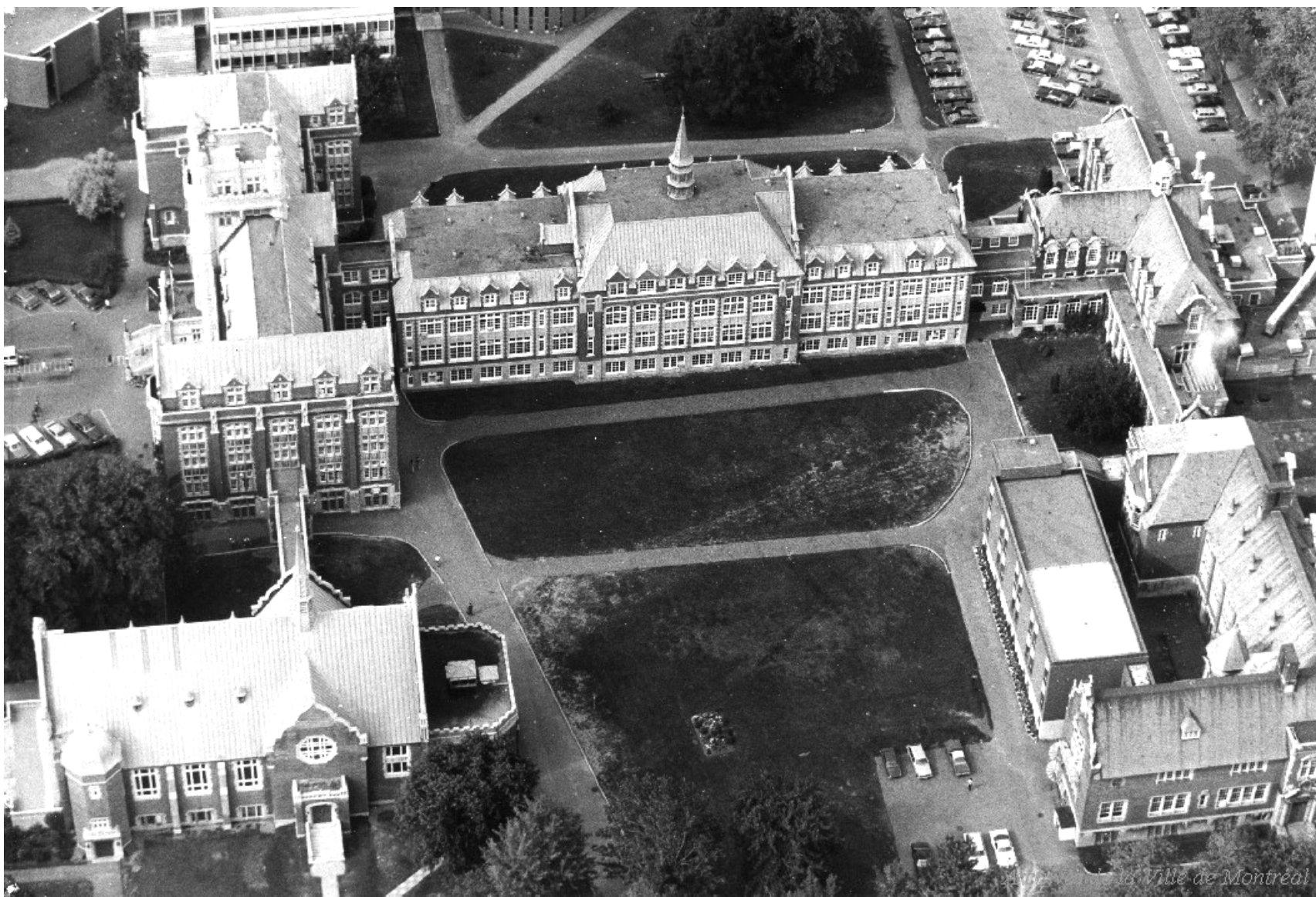
4.121 Vue aérienne vers l'ouest du campus au nord de la rue Sherbrooke Ouest, vers 1978 (VM166-R3080-2_71410-019, AVM)
