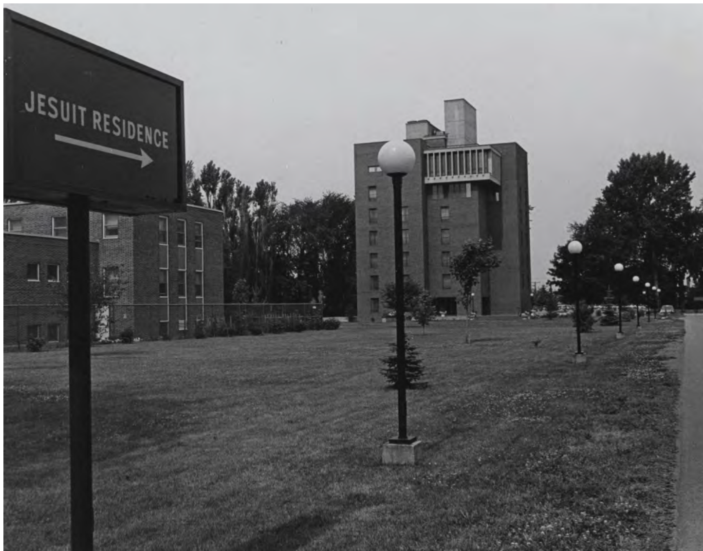
4.97 Vue à partir du sud de la Résidence des Jésuites (JR) en 1974 (Photo de Paul Hrasko, I002-02-1745, UC-GDA)
