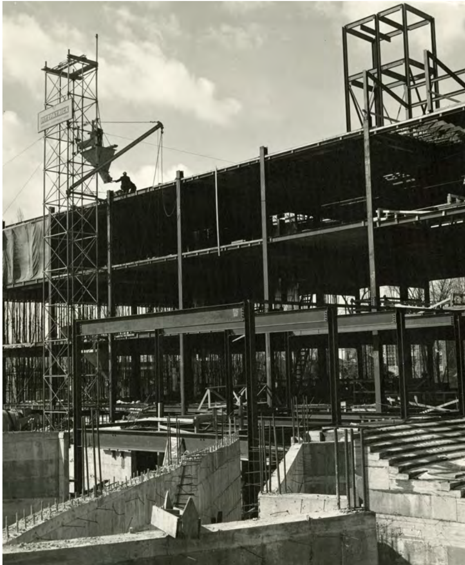
4.61 Vue du Pavillon des sciences Drummond (CJ), avec sa structure d'acier, en construction, vers 1961 (I002-02-4147, UC-GDA)
