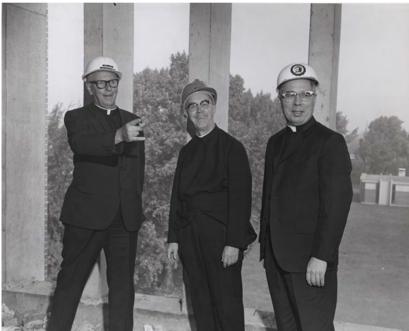
4.96 Les pères Ryan, Swain et Malone dans la salle à dîner au dernier étage de la Résidence des Jésuites (JR) lors de sa construction, en 1968-69; la salle à dîner des résidences étudiantes Hingston Hall (HC) est visible au fond (I002-02-36, UC-GDA)
