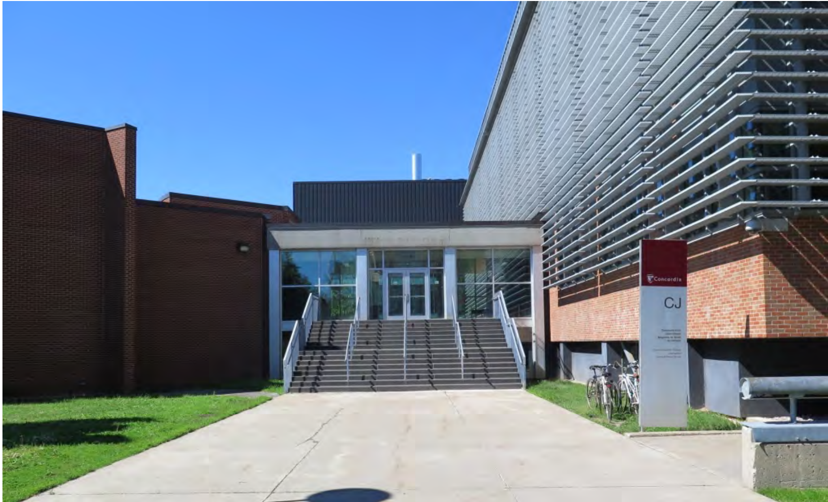
4.170 Vue vers l'ouest de l'entrée principale du Pavillon Communication et Journalisme (CJ); l'entrée pour les livraisons et les personnes à mobilité réduite est à droite, l'auditorium est à gauche et le Centre de génomique structurale et fonctionnelle (GE) est au fond (Susan D. Bronson, 2016)
