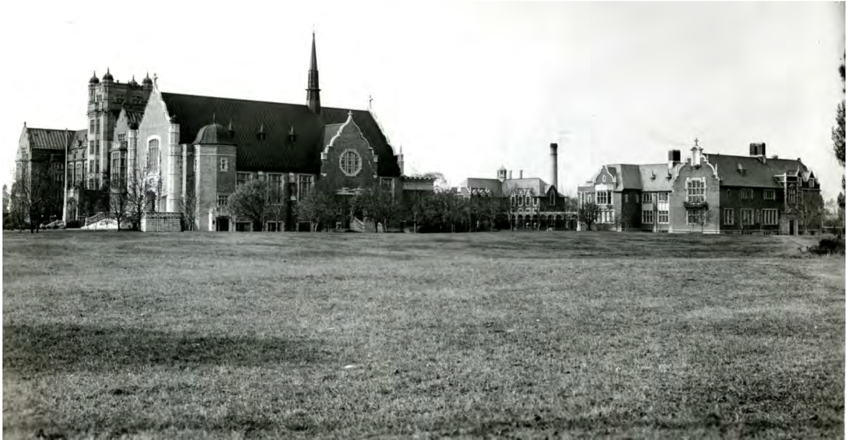
4.44 Vue du campus, prise du sud-est après 1933 (P013-02-004, UC-GDA)
