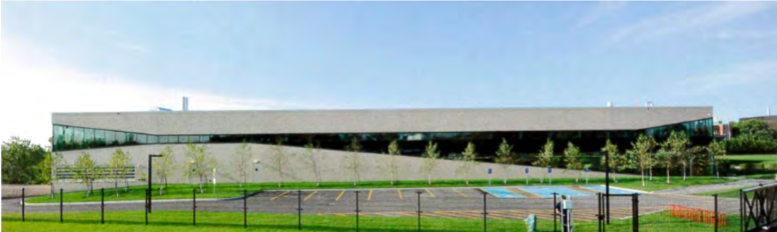
4.199 Façade est du Centre PERFORM (SAIA BARBARESE TOPOUZANOV, « Concordia Centre PERFORM... », Op. cit., p. 8)
