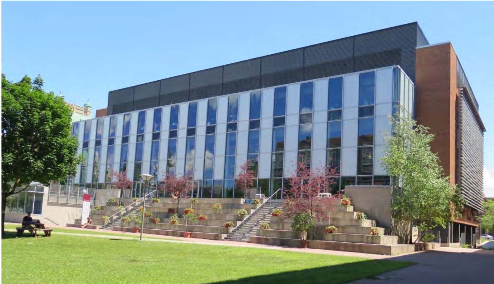
4.169 Vue à partir du nord-ouest du quadrilatère ouest de l'ajout du Pavillon Communication et Journalisme (CJ), avec l'atrium and le podium en gradins (Susan D. Bronson, 2016)
