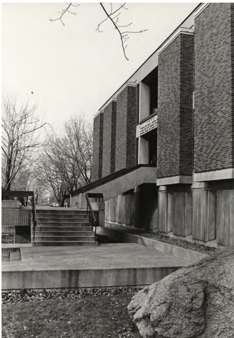
4.73 L'entrée principale avec son escalier en béton et la grosse pierre de granit qui fut trouvée lors de l'excavation (I002-02-1682, UC-GDA)
