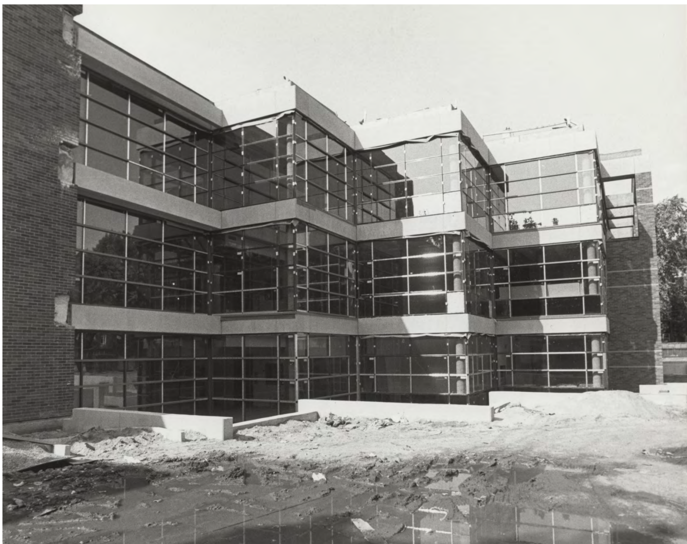
4.138 Vue de l'agrandissement en 1988, lors de sa construction, montrant sa fenestration généreuse et la configuration de son mur rideau, qui répond au site (Boîte 4881, UC-GDA)
